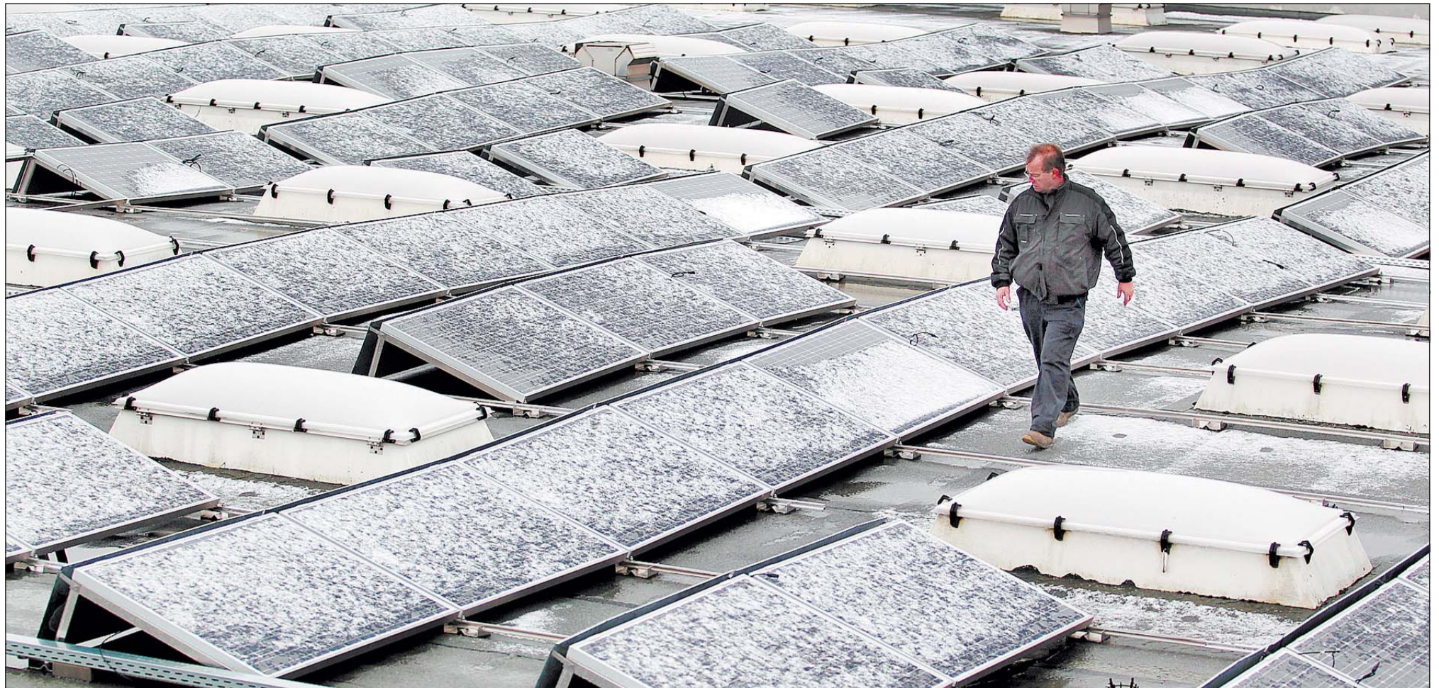
Bauleiter Gerd Brockmeyer (Archimedes) inspiziert die neue Photovoltaikanlage auf dem Dach der Wemhöner-Produktionshalle. Mit ihr soll ein Ausstoß von jährlich 228 Tonnen Kohlendioxid vermieden werden. 1971 hatte sich Wemhöner im Industriegebiet Heidsiek als erstes Unternehmen in der Planckstraße angesiedelt. Fotos: Moritz Winde
