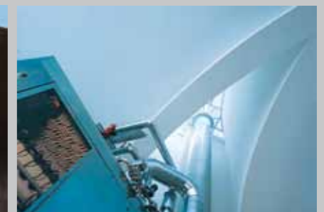
Errichtung, Nahwärmanbindung Netzinfrastruktur: Alles aus einer Hand.
